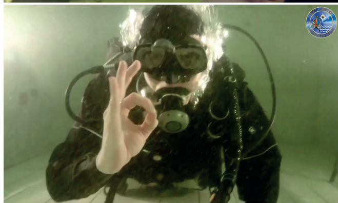
Рис. 3-4. Нанесение водолазами материала для подводного ремонта в бассейне МЧС
